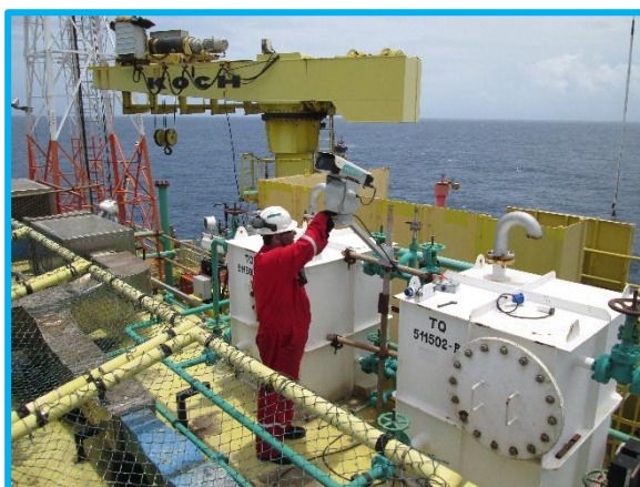
Figura 3: Instalação do dispositivo laser Avix Autonomic, na plataforma 3R-1, Campo de Peroá e Cangóá.
