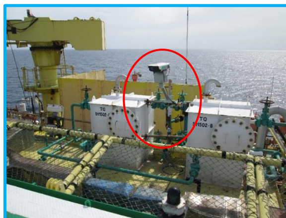
Figura 4: Dispositivo a laser Avix Autonomic instalado na plataforma 3R-1, Campo de Peroá e Cangóá.
